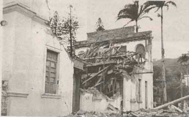
Prédio que abrigou a Rádio Difusora (onde hoje está o Restaurante Chedão), com o registro do seu desabamento nos anos 80.
